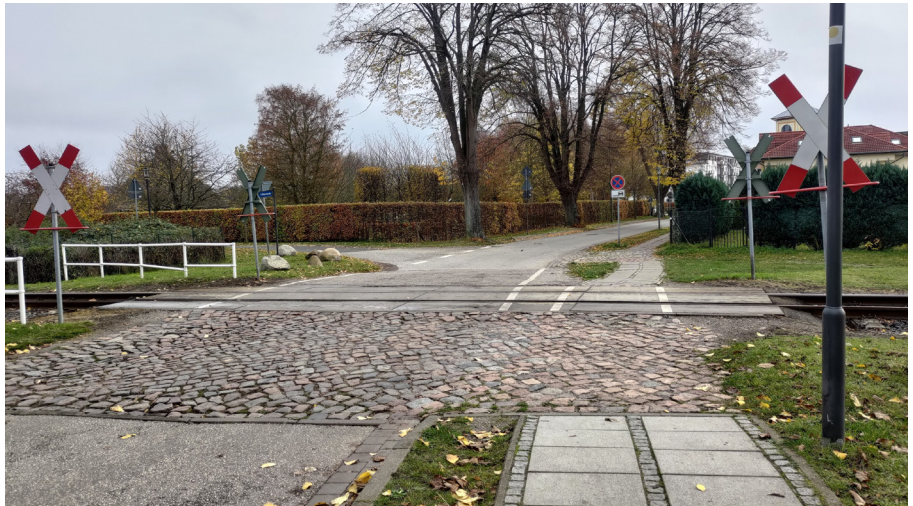
Der Bahnübergang an der Ulmenstraße ist mit Rollator eine Herausforderung
